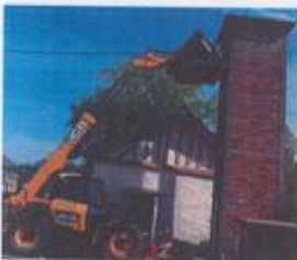
Travaux d'aménagement du transformateur
